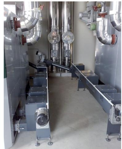
En esta imagen pueden observarse los depósitos de cenizas conectados mediante el sistema sinfín, una solución de 2 calderas en cascada HERZ.
