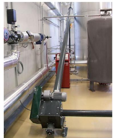
Ejemplo de sinfín que transporta en vertical (aprox. 4 m) las cenizas que generan 2 equipos HERZ hasta un depósito de cenizas de 2m<sup>3</sup> que se encuentra fuera de la sala de calderas.
