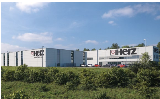
Instalaciones HERZ en Pinkafeld
